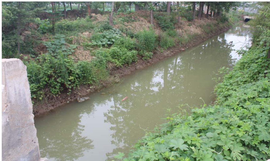
薛套沟现状照片
