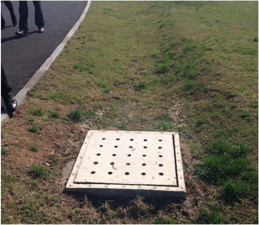
道路下凹式绿地及雨水口布置
