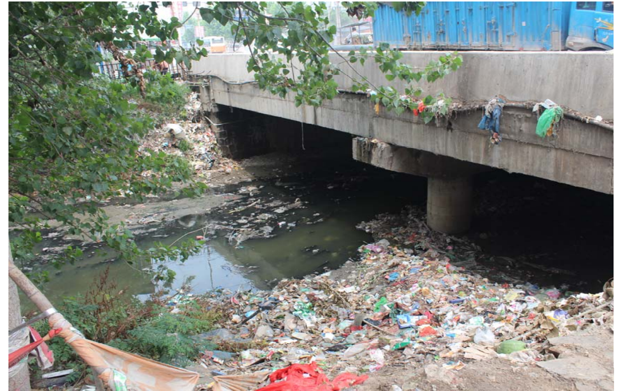
总干渠下游现状照片
